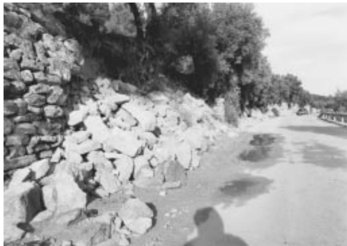
La carretera d'accés a la Portellada vorejada per una successió de portells causats per les inundacions d'octubre
